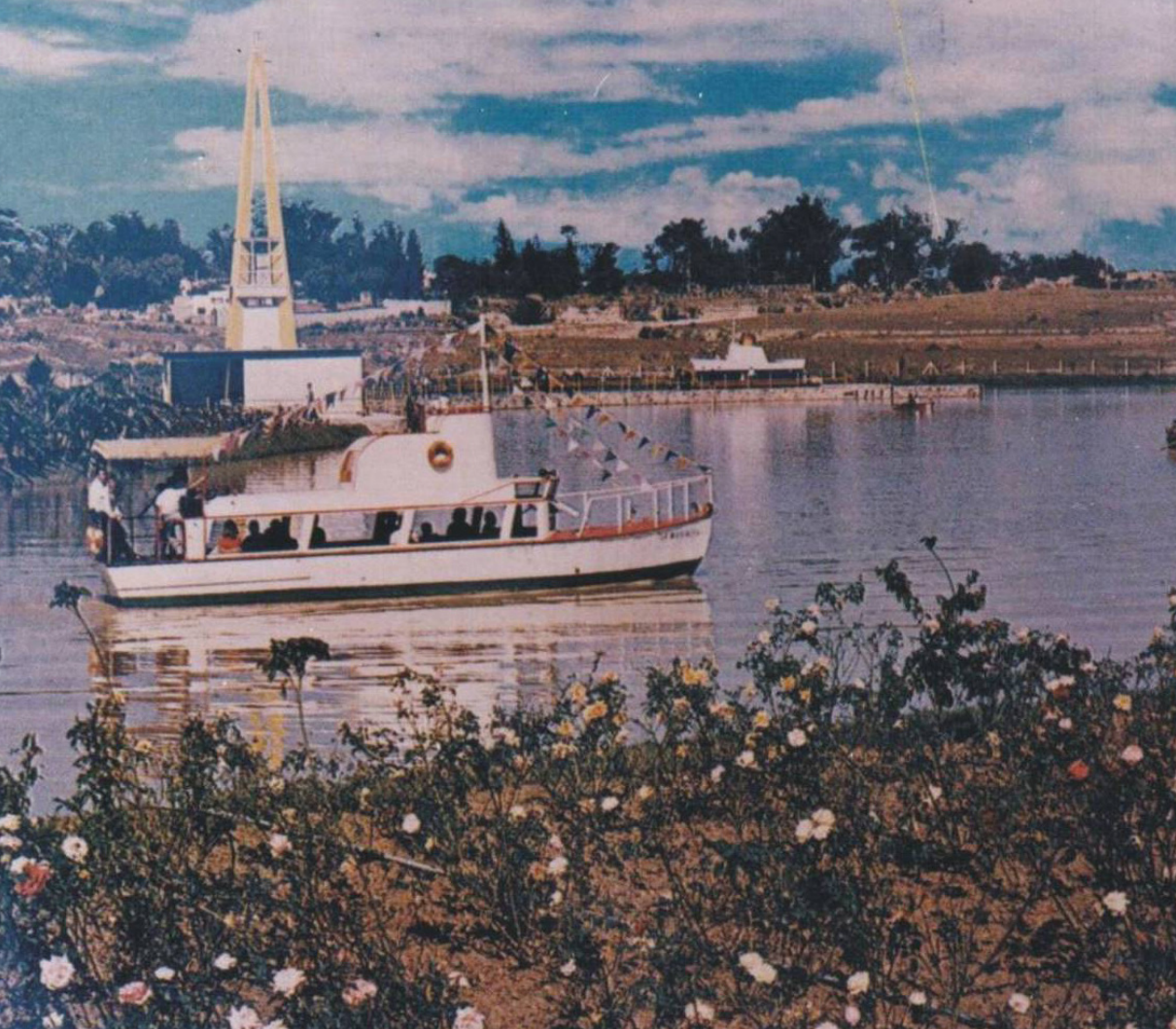
La presa de Zoquipan, después parque Ávila Camacho. AGMZ. Col. Francisco Montoya Rivas.
