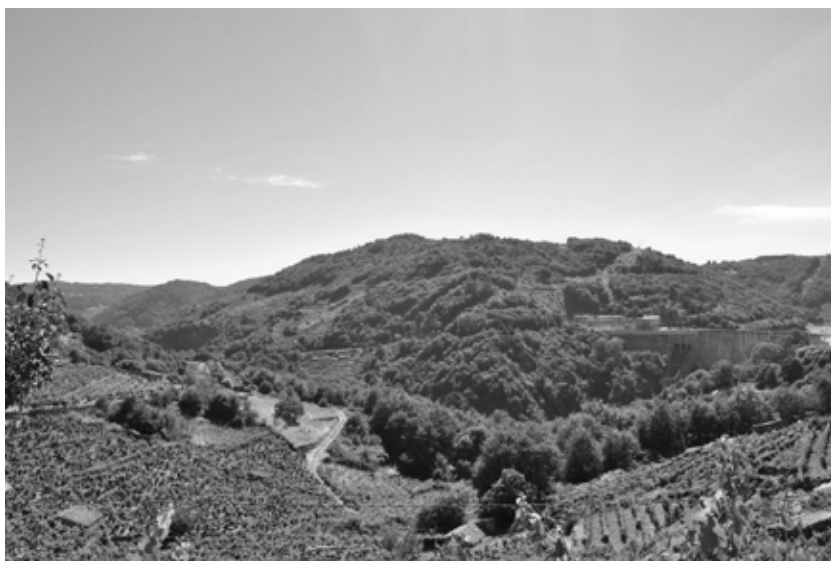
FIGURA 3. VISTA GENERAL DE LA PRESA DE BELESAR
