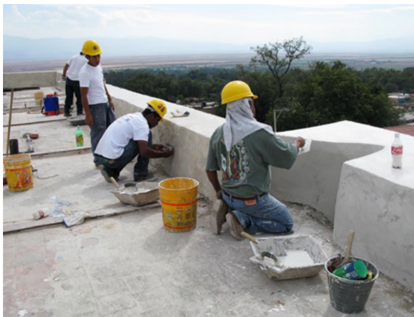
FIGURA 4. OBREROS TRABAJANDO EN LA AZOTEA DEL TEMPLO
