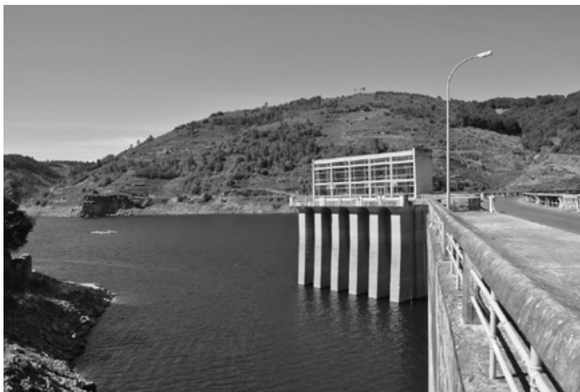
FIGURA 4. EDIFICIO DE LA SUBESTACIÓN DE BELESAR
