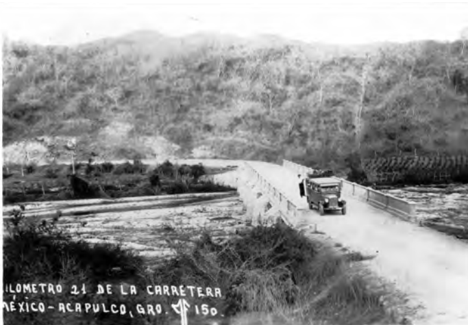
Imagen 1. Aspecto de la Carretera México-Acapulco, Guerrero
